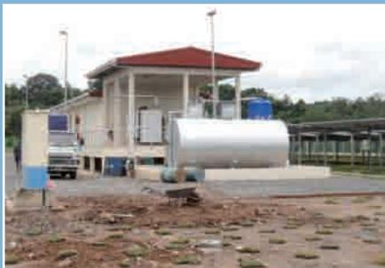
A sinistra, una rete di pannelli solari da 430 kilowatt installata dalla Optimal Power Systems nell'Est della Malesia produce energia per il migliaio di abitanti di un paese vicino. Un trasformatore permette di convertire all'incirca 250 kilowatt di corrente continua in corrente alternata da ridistribuire all'interno del villaggio. Nelle giornate di sole, quando i pannelli lavorano al massimo della loro capacità, l'energia in eccesso viene immagazzinata nelle batterie.
